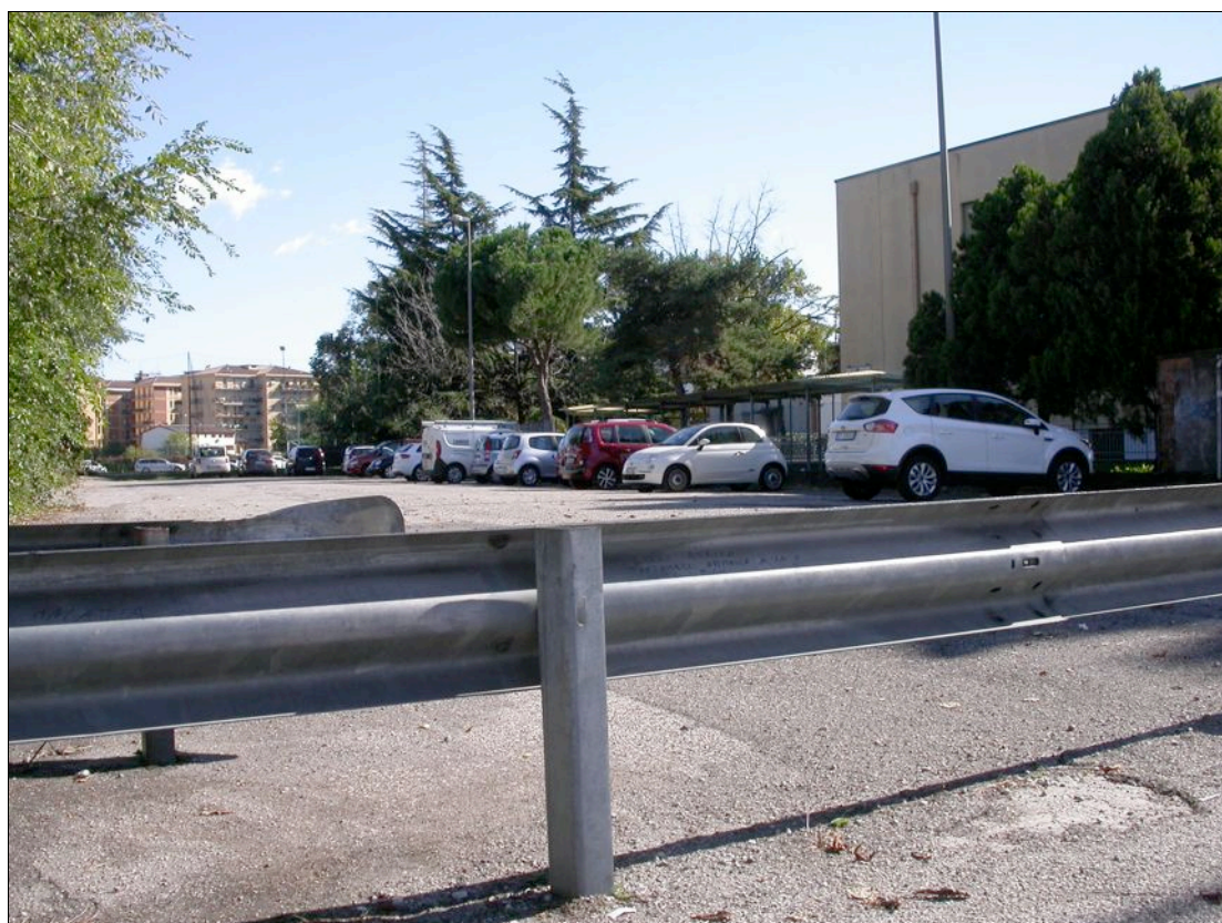
Foto 2: Vista del piazzale e dei guard rail
